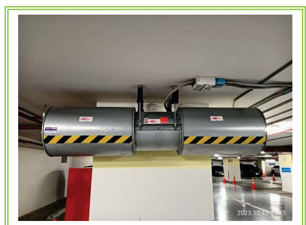
รูปที่ 3-6 พัดลมระบายอากาศ บริเวณลานจอดรถชั้นใต้ดิน
