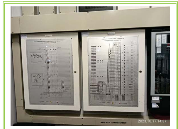
รูปที่ 3-47 แผงควบคุมระบบเตือนอัคคีภัย (Fire Alarm Control Panel : FCP)
