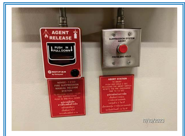
เครื่องแจ้งเหตุโดยใช้มือถือ (Fire Alarm Manual Station)
