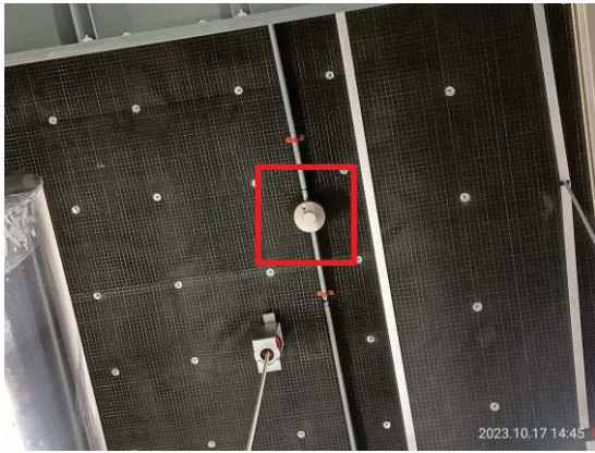
รูปที่ 3-33 เครื่องตรวจจับควัน (Smoke Detector) ภายในห้องเครื่องหม้อแปลงไฟฟ้าโครงการ
