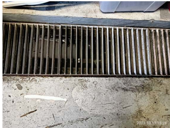
รูปที่ 3-30 ท่อรวบรวมน้ำล้างพื้นบริเวณห้องพักมูลฝอย
