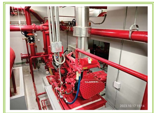
รูปที่ 3-41 เครื่องสูบน้ำดับเพลิง (Fire Pump)
